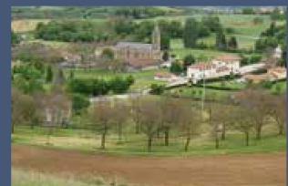
P14 CHASSELAY Porte de Chambaran
